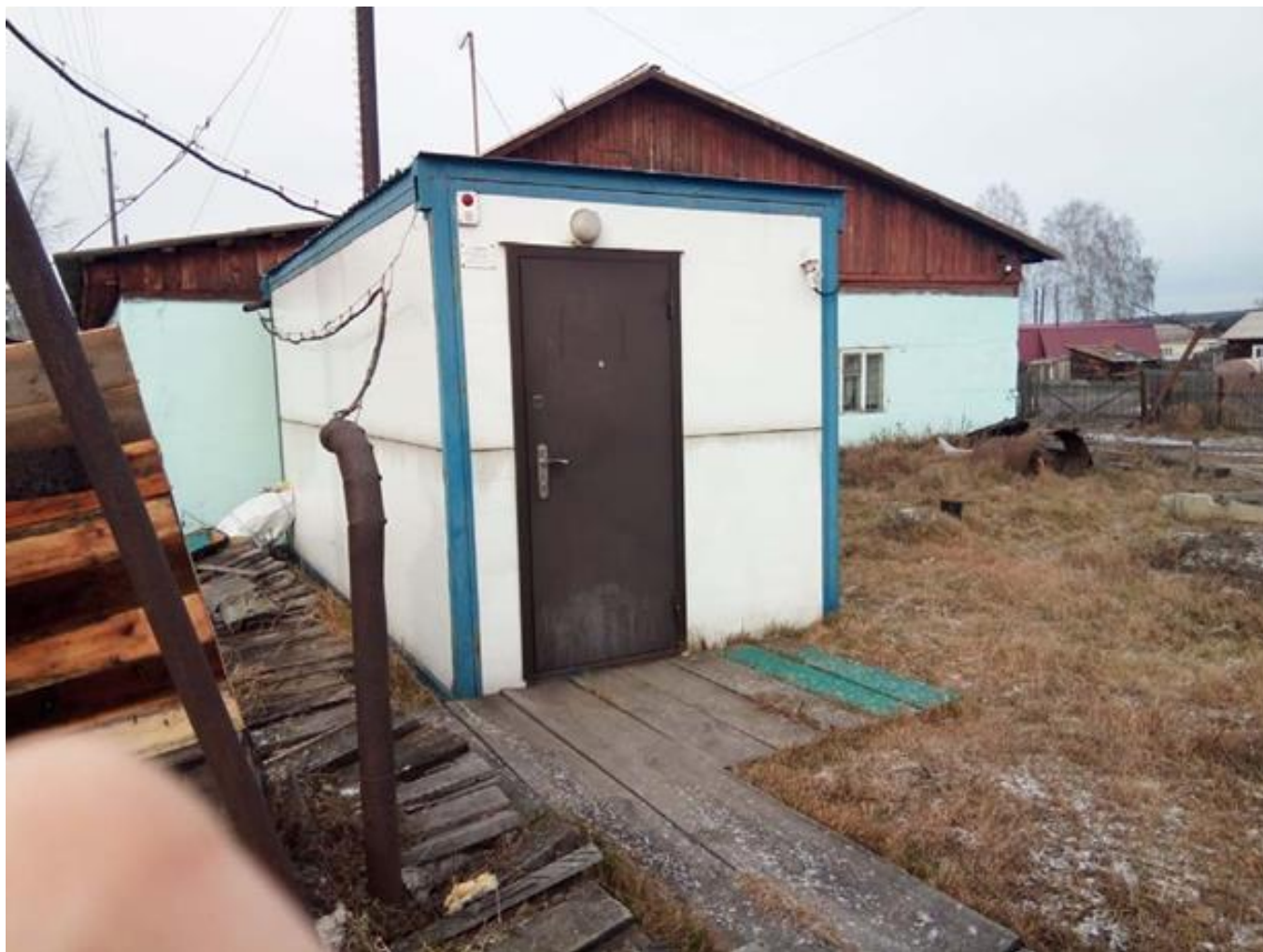
Рисунок 1.21 – Водозаборные сооружения МУП «ПП ЖКХ № 5 п. Стрелка» «Енисей», фильтровальная станция
