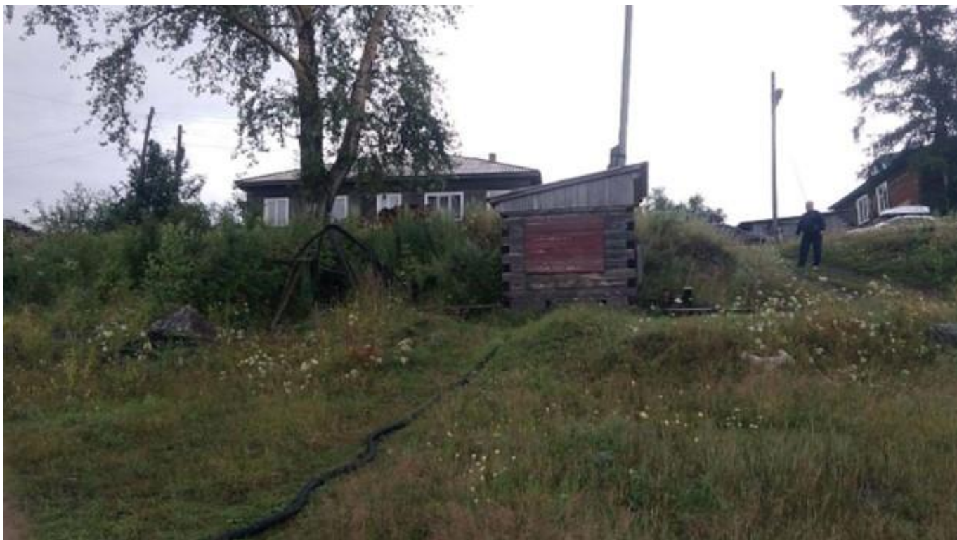
Рисунок 1.19 – Водозаборные сооружения МУП «ПП ЖКХ № 5 п. Стрелка» «Енисей», склад с гидрантом
