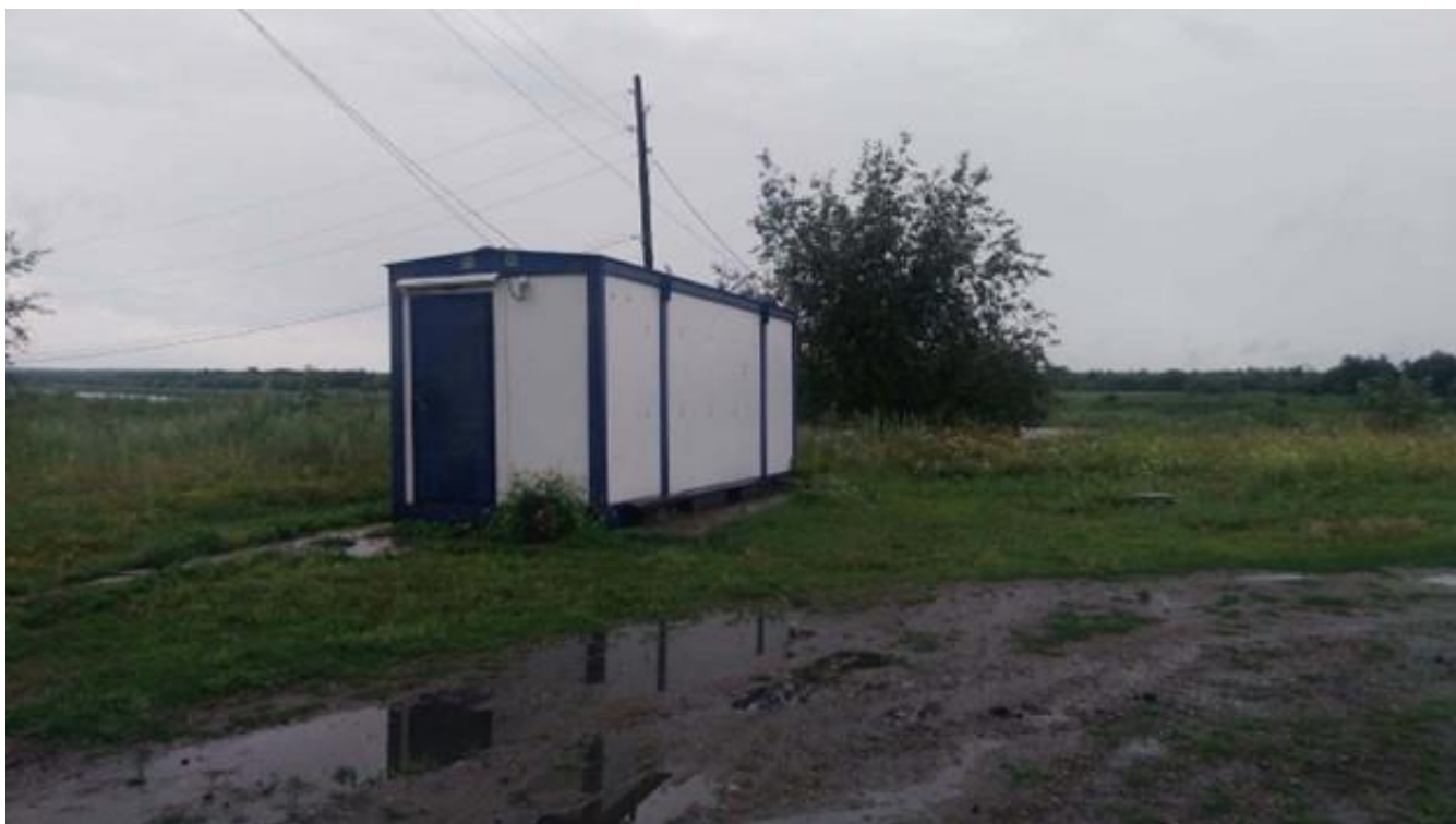
Рисунок 1.16 – Водозаборные сооружения МУП «ПП ЖКХ № 5 п. Стрелка» «Протока», станция очистки
