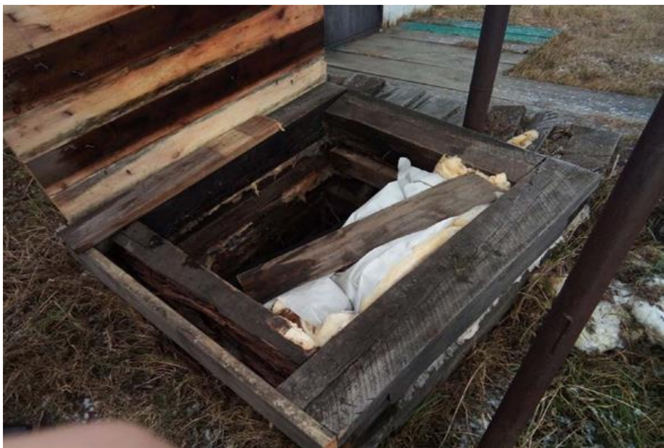
Рисунок 1.20 – Водозаборные сооружения МУП «ПП ЖКХ № 5 п. Стрелка» «Енисей», бетонный резервуар
