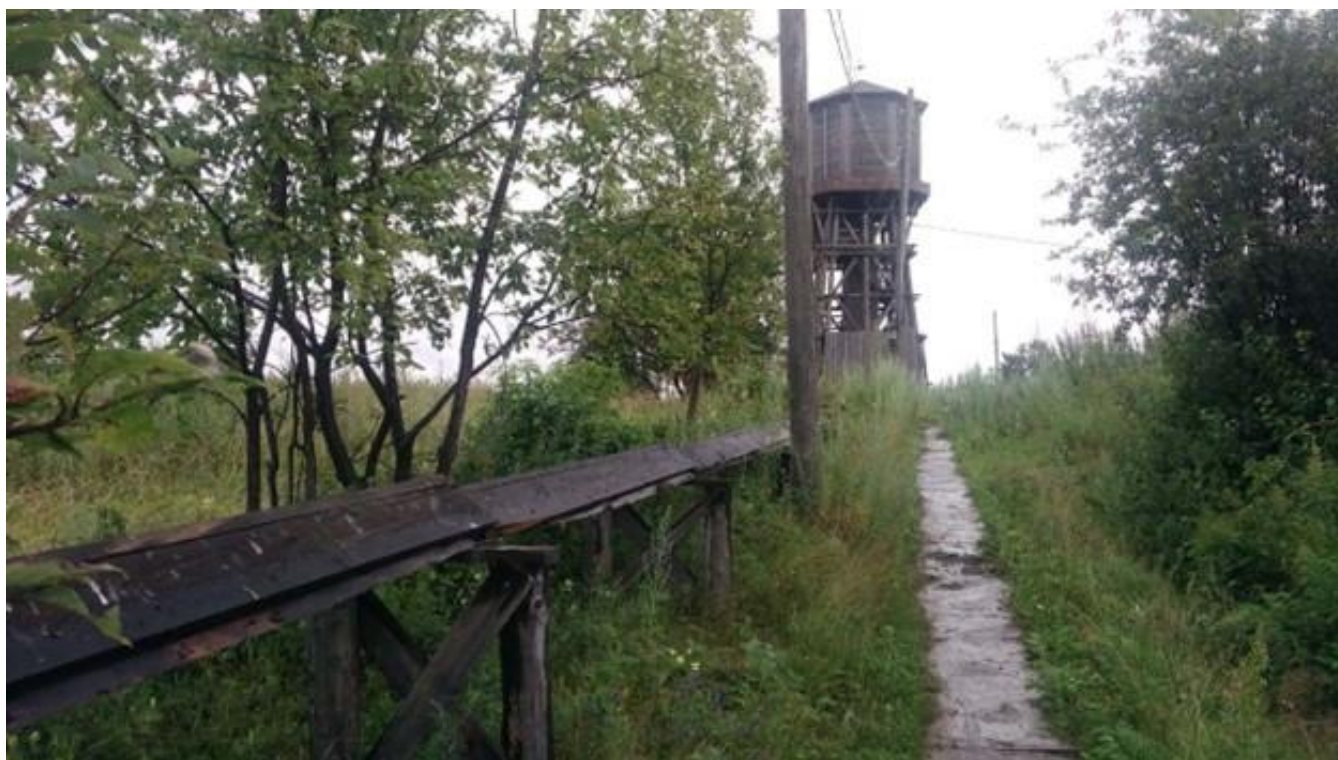
Рисунок 1.17 – Водозаборные сооружения МУП «ПП ЖКХ № 5 п. Стрелка» «Протока», накопительный резервуар
