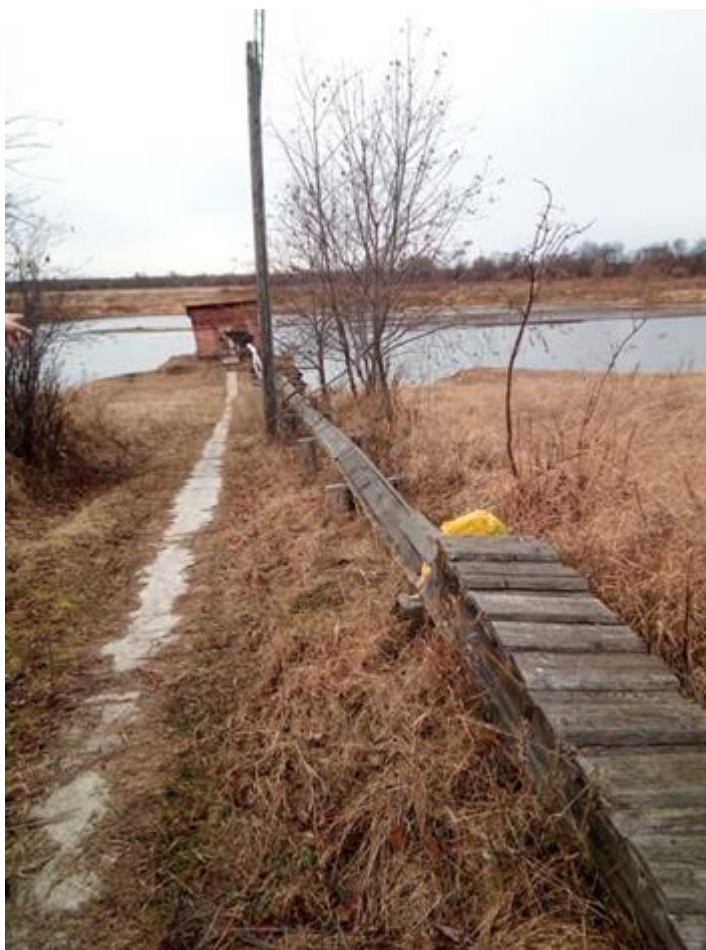
Рисунок 1.15 – Водозаборные сооружения МУП «ПП ЖКХ № 5 п. Стрелка» «Протока», насосная станция
