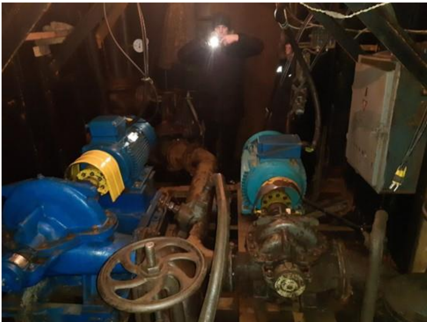
Рисунок 1.13 – Насосная станция 1го подъёма водозаборного сооружения МУП «ЖКХ г. Лесосибирска», внутреннее состояние
