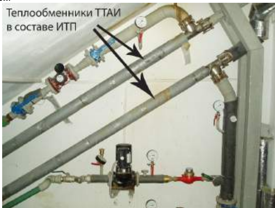
Рисунок №3. Модуль приготовления ГВС из-за стесненных условий в подвале размещен под лестницей.
